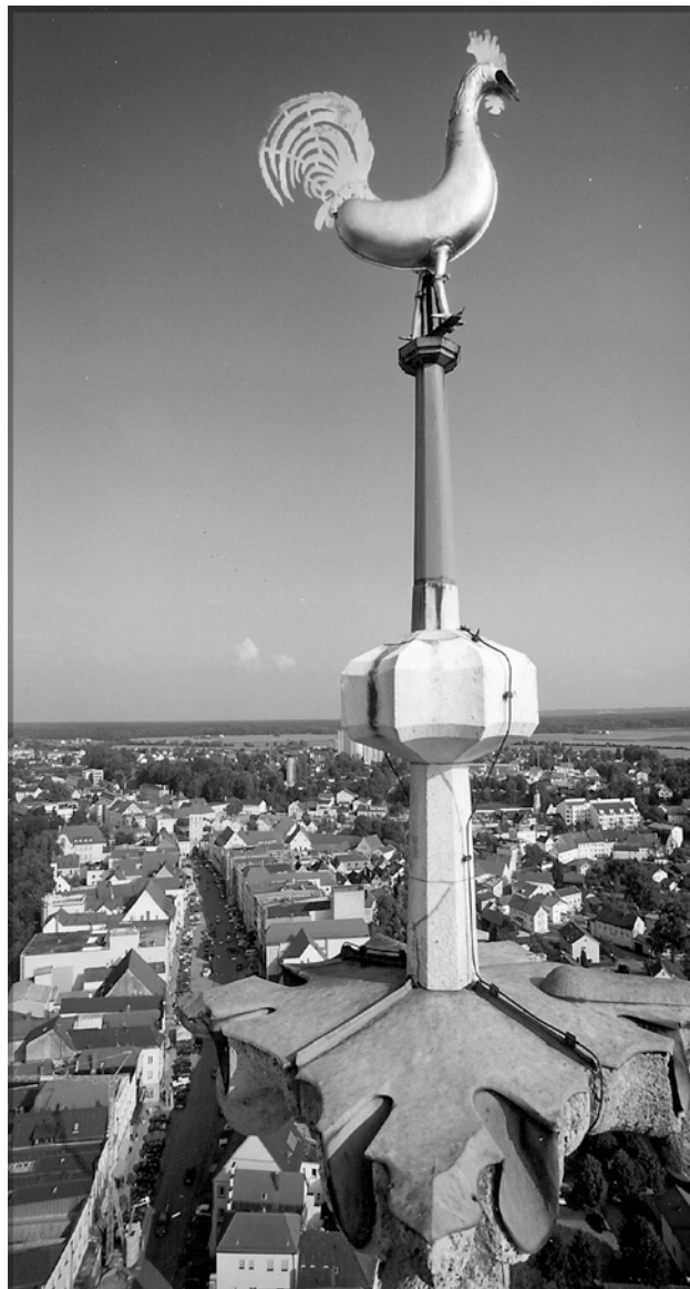
Neuötting vom Baukran der Nikolauskirche während der Renovierung 1993
